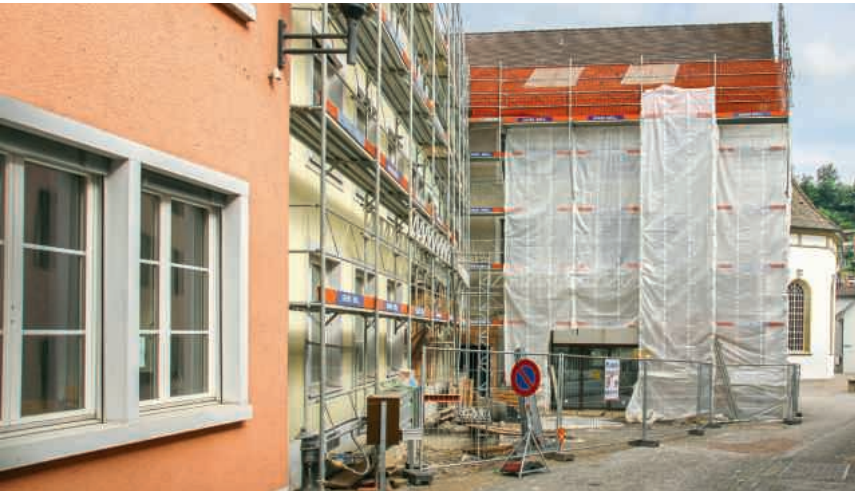
Baustelle Effingerhof: Lieferengpässe beim Baumaterial
