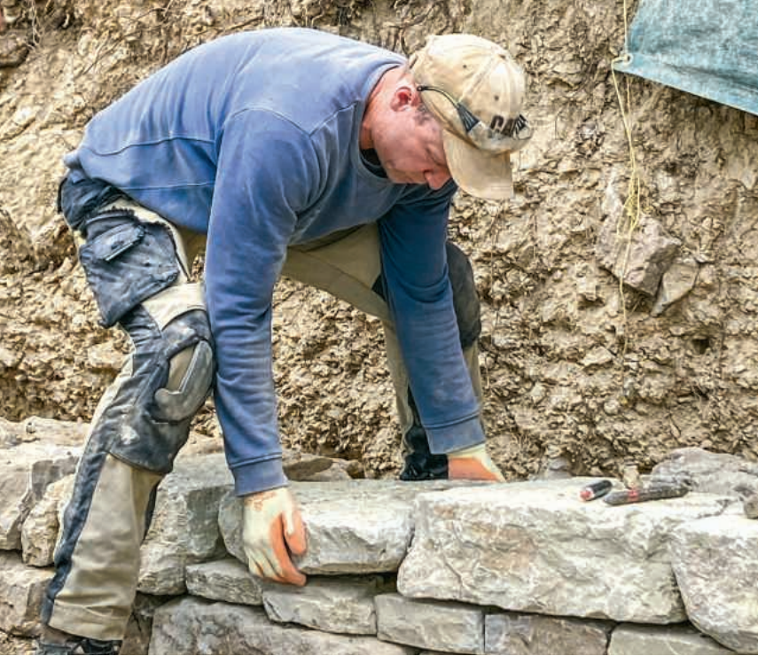
Arbeit an der Trockenmauer
