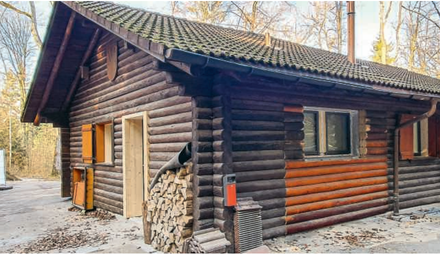
Die renovierte Waldhütte Lupfig wurde durch Vandalen verschmiert
