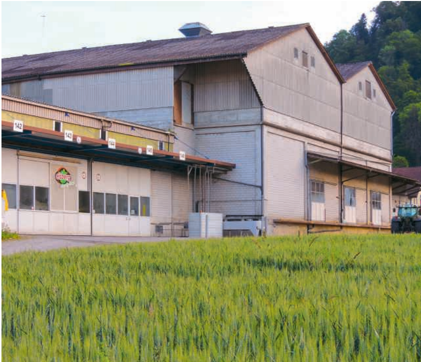
Auf dem Areal soll eine innovative Mischnutzung entstehen
